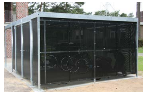
Beklædning med perforeret stålplade pulverlakeret i sort
